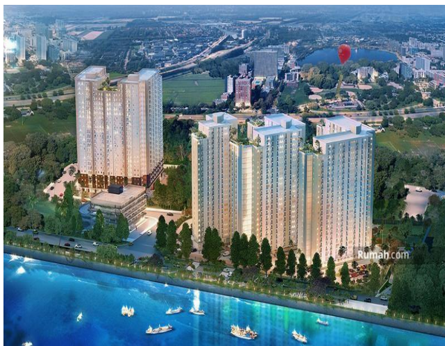
Gambar 2.1 Proyek Apartemen Pluit Sea View
