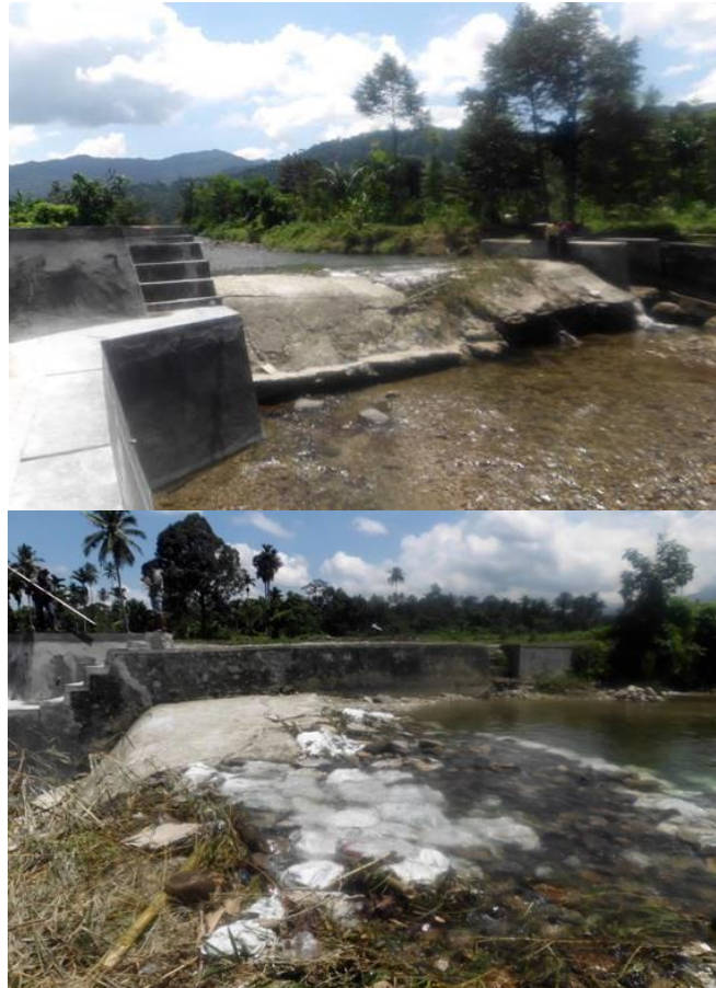
Gambar 1.1 Kondisi Terkini Bendung (Sumber dari: Dokumentasi Lapangan,2021)
