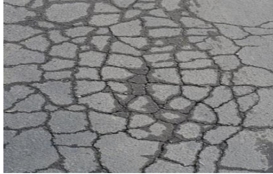
Gambar 2.4 Retak Kulit Buaya
