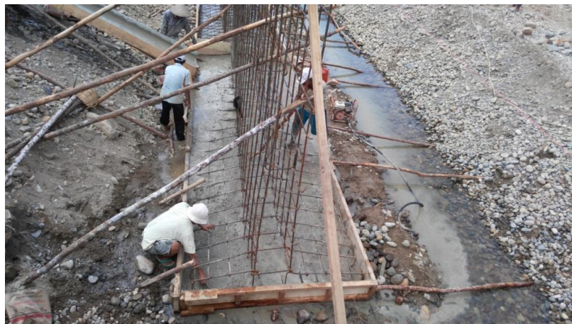
Gambar 1.4 : Pengerjaan Normalisasi Sungai Batang Bayang
