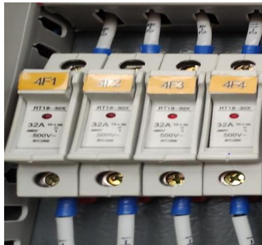
Gambar 2.21 Fuse pada switch
