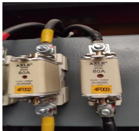
Gambar 2.22 Fuse pada kontaktor 50A
