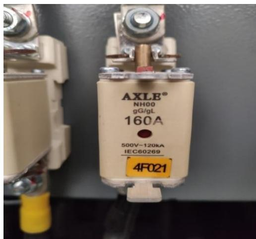
Gambar 2.23 Fuse pada kontaktor 100A
