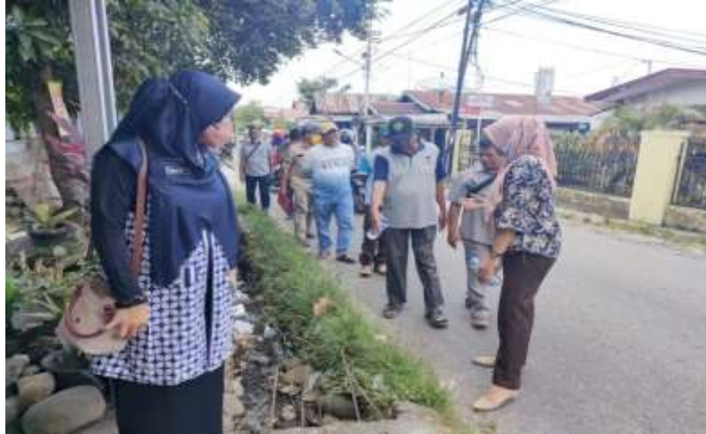
Gambar 1.1 Drainase yang bermasalah
