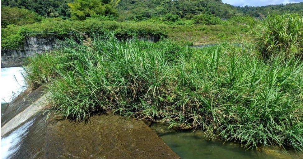
Gambar 1. 1 Kondisi Bendung Bandar Baru Batang Tampunik (Sumber: Dokumentasi survei lapangan)
