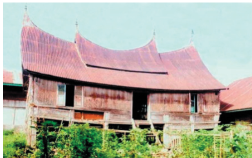
Gambar 2.6 Bangunan Rumah Gadang dengan tangga tanpa atap di Pariangan Padang Panjang (Couto, N.1998)
