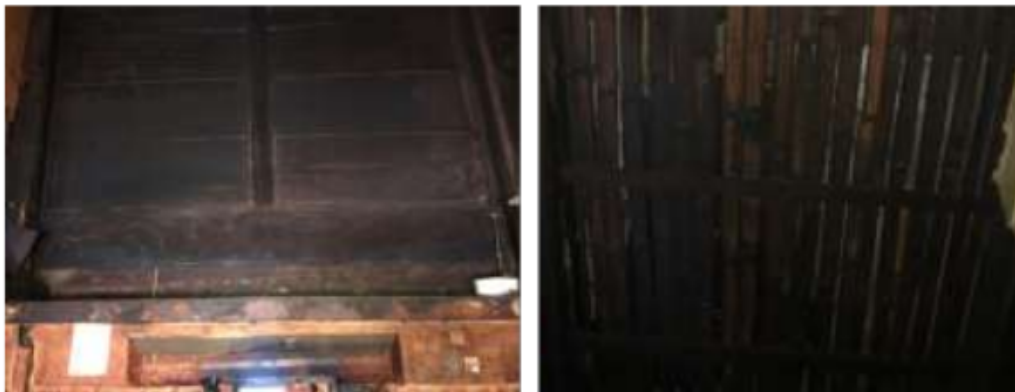
Gambar 5.12 Material Ruang dalam Pada Bangunan Rumah Larik Sumber : Hasil Survey Tahun 2021
