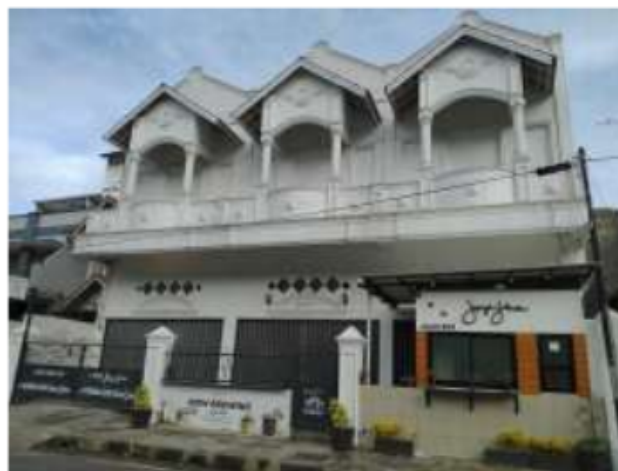
Gambar 5- 27 Bangunan Kopi Janji Jiwa
