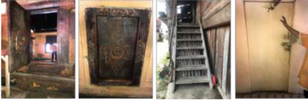
Gambar 5.10 Penghubung Antar Ruang Pada Bangunan Rumah Larik Sumber : Hasil Survey Tahun 2021
