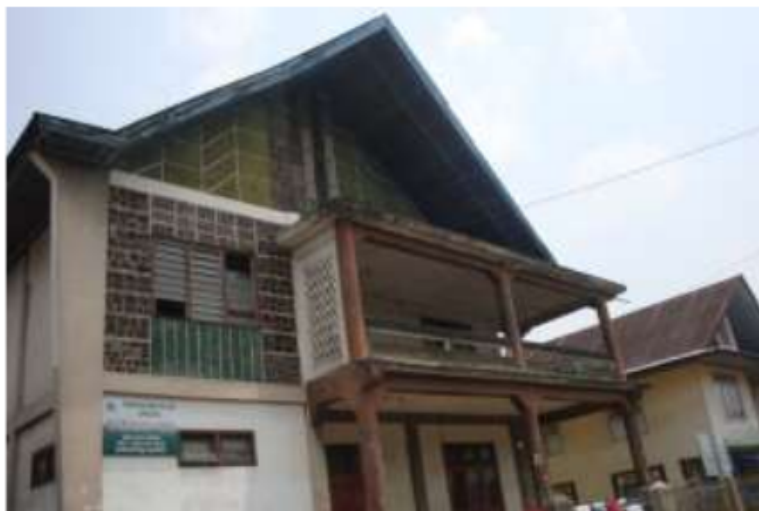
Gambar 27. Rumah Jangki Permanen menggunakan Material Semen, Bata dan Batu Terawang
