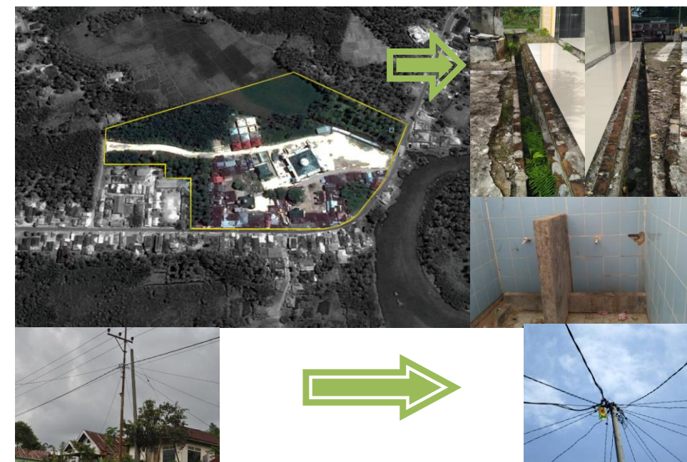
Gambar IV.21 Air bersih dan listrik
