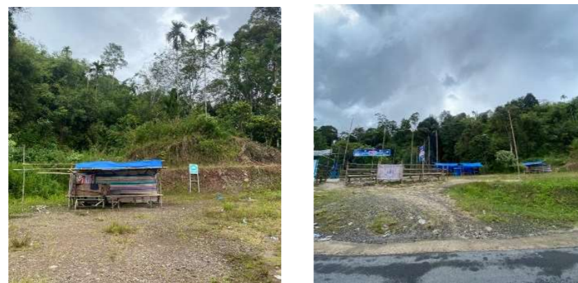
Gambar 1.14 Kondisi Existing Site
