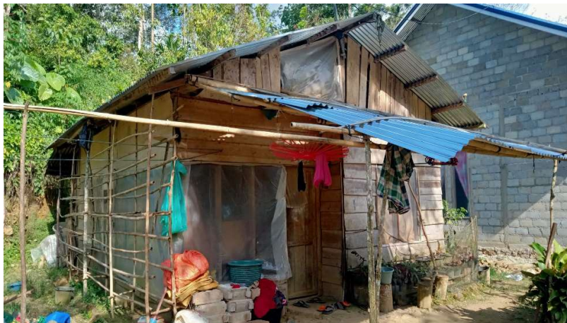
Gambar 1. 2 Rumah dengan struktur bangunan, pencahayaan, sanitasi yang sangat tidak memadai
