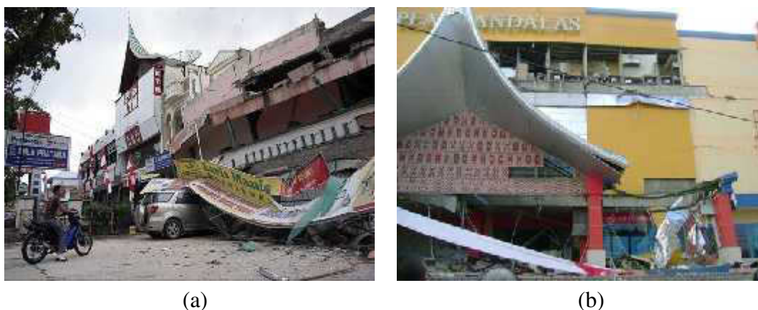
Gambar1.1Kerusakan Akibat Gempa Bumi (a) Gempa Sumbar 2007 ; (b) Gempa Sumbar 2009, (BNPB).
