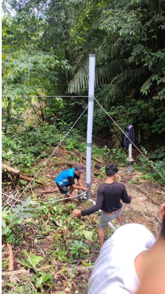
Gambar 5. 2 Pemasangan pompa hidram di wilayah perkebunan
