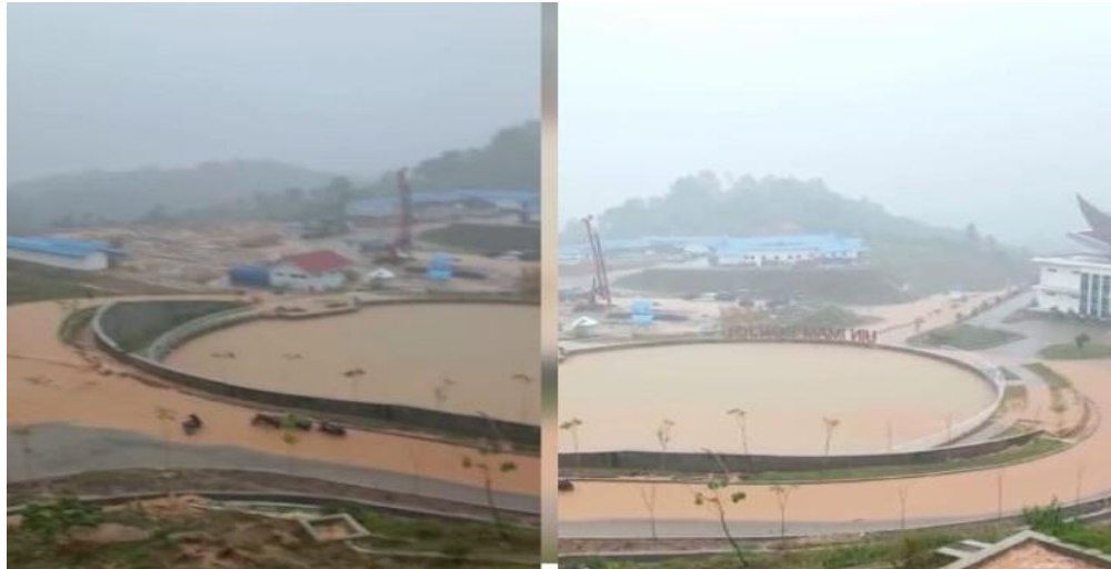
Gambar 1. 2 Kondisi Kampus III UIN Saat Diguyur Hujan (Sumber : Padangkita, 2022)
