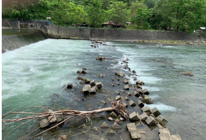
Gambar 1.1 Kondisi Bendung di Lapangan
