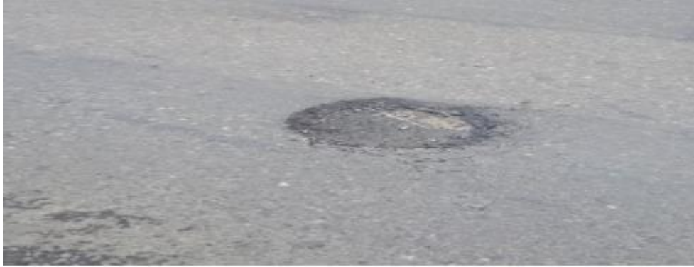
Gambar 2.20. Kerusakan Lubang
