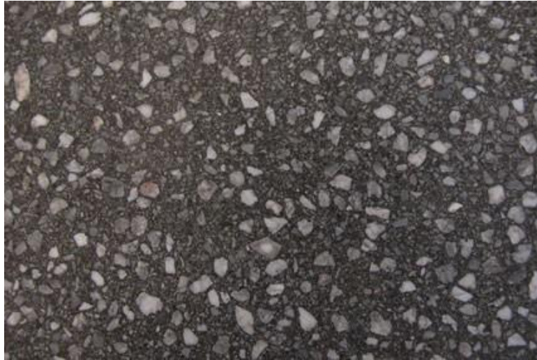
Gambar 2.19. Kerusakan Pengausan Agregat
