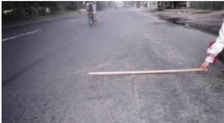
Gambar 2.25. Kerusakan Mengembang/Jembul
