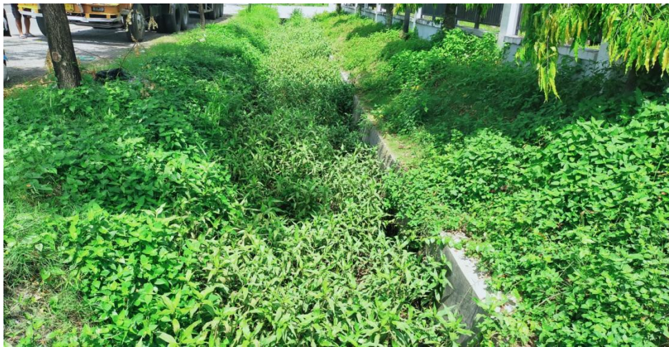
Gambar 1.1 adanya penumpukan sedimentasi dan tumbuh-tumbuhan pada drainase Sumber: Dokumentasi Pribadi
