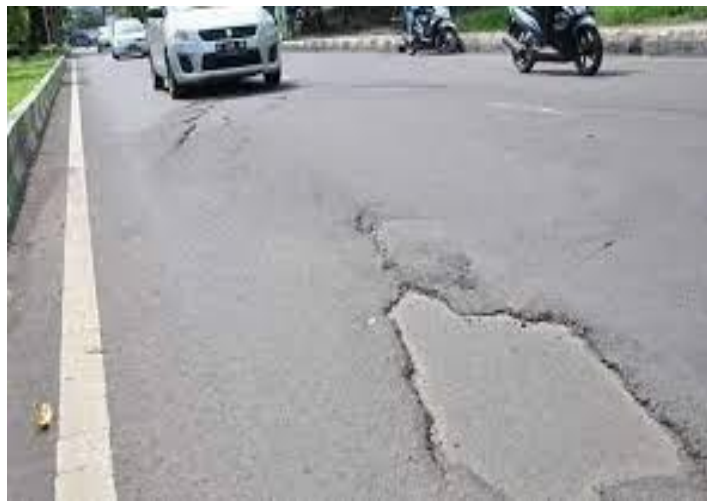
Gambar 2.21 Pengelupasan ( Delamination )
