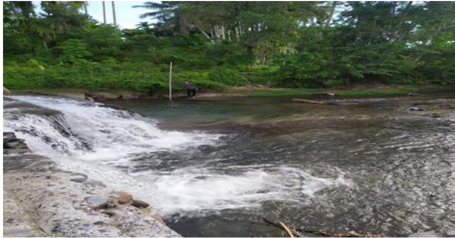
Gambar 1. 2 Kondisi Bendung Manggis Barangan (Sumber : Dokumentasi Lapangan)
