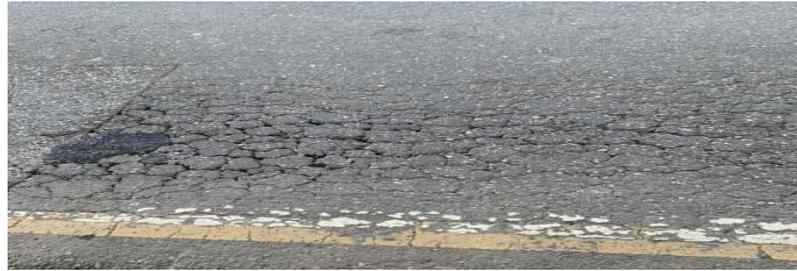
**Gambar 2.3 Retak Kulit Bauaya (*Alligator Cracking*)**
