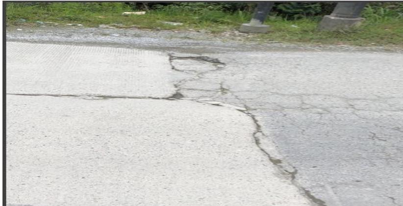
**Gambar 2.8 Retak Sambung (*Joint Reflection Cracking*)**
