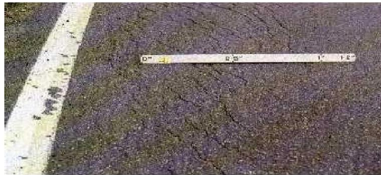
**Gambar 2.12 Retak Bulan Sabit (*Slippage Cracking*)**
