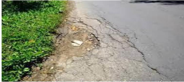
**Gambar 2.7 Cacat Tepi Perkerasan (*Edge Cracking*)**
