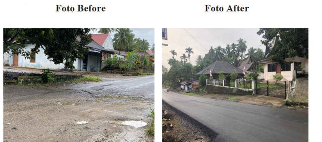
Gambar : Kondisi jalan sebelum di perbaikidan sesudah di perbaiki di Nagari Lubuak Jantan Lintau Buo Utara sebelum diperbaiki
