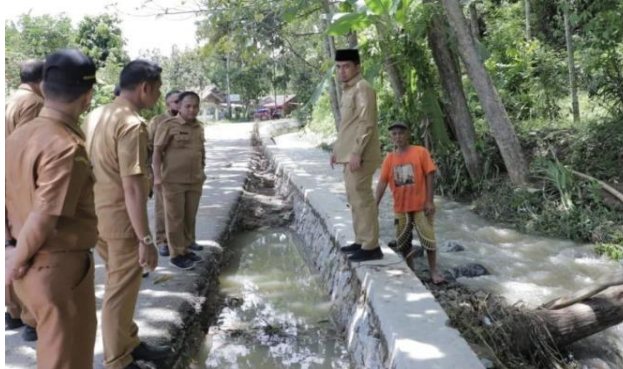
Gambar 1.1 kondisi drainase dilapangan (Sumber : padekjawapos.com)
