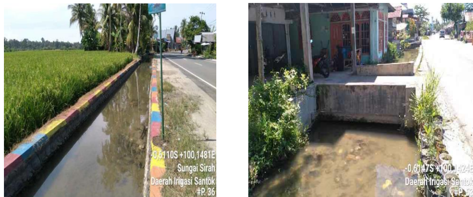
Gambar 1. 1 Kondisi Saluran Irigasi (Sumber: PUPR, 2022)
