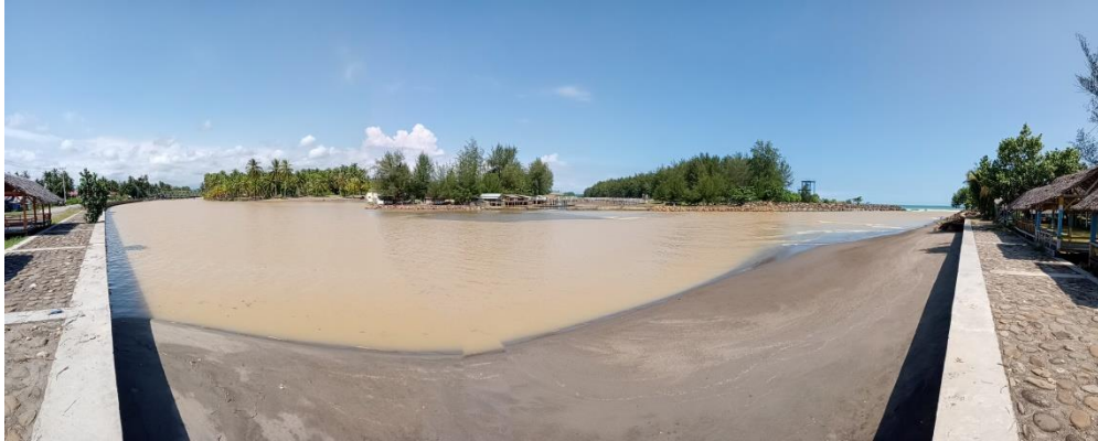
Gambar 2.1 Sungai Ulakan Tapakis (Sumber : Dokumentasi Survey Lapangan)
