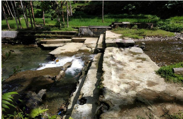
Gambar 1.1 Kondisi Bendung Batang Kalawi (Sumber : Dokumentasi Survei,2021)
