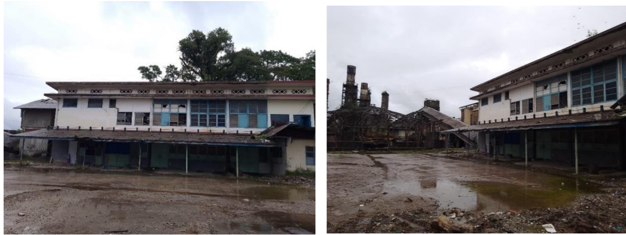
Gambar 1.10 Kondisi Tampak Depan Bangunan gudang diadaptasi
