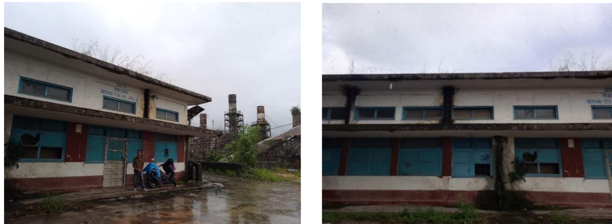
Gambar 1.11 Kondisi Tampak belakang Bangunan Gudang diadaptasi
