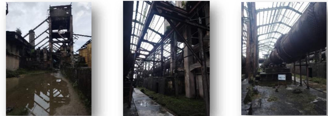
Gambar 1.14 : kondisi bangunan pabrik Indarung IDokumentasi : 18 november 2022
