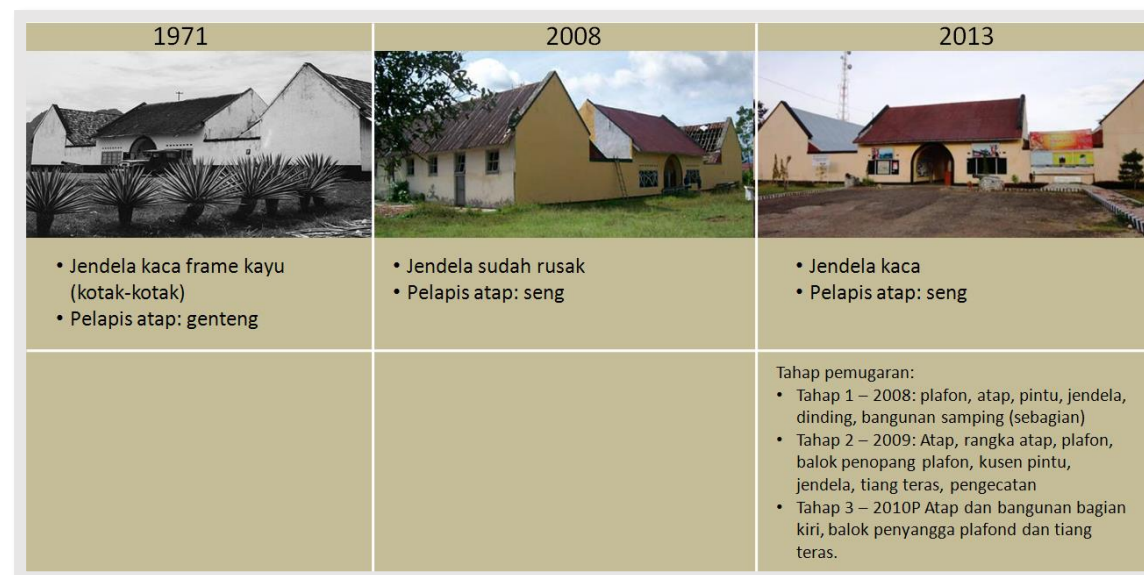
Gambar 1. 9. Kondisi Keterawatan Bangunan.
