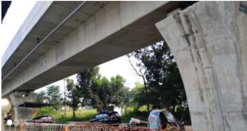
Gambar 1.4 Gambar Jembatan Layang Kereta Api (JLKA) Medan P151 – P152
