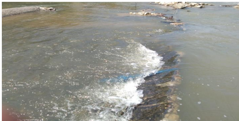
Gambar 1.2 Kondisi kolam olak (Dokumentasi Survey Lapangan pada 17 februari 2020)
