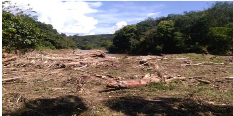
Gambar 1.1 Kondisi Bendung Terkini Pasca Banjir Bandang (Dokumentasi Survey Lapangan pada 17 februari 2020)
