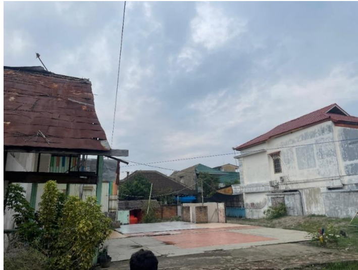
Gambar 1. 16 Kondisi bangunan Sekolah Alam Minangkabau
