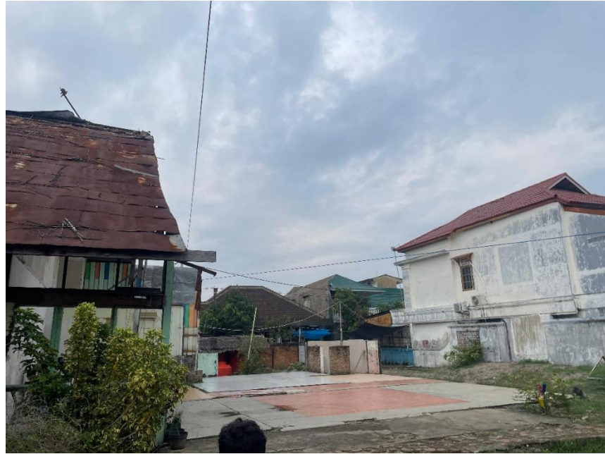
Gambar 1. 1 Kondisi Pembongkaran Bangunan Sekolah Alam Minangkabau Sumber : Dokumentasi Penulis
