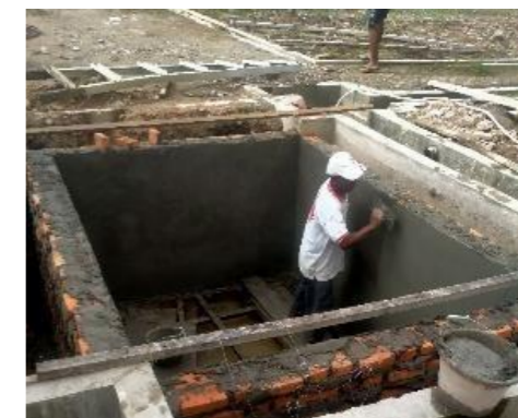
Gambar 1.3 Kondisi Fisik Pembuatan Septitank Asrama Universitas Bung Hatta Sumber: Survey Lapangan penulis 2023
