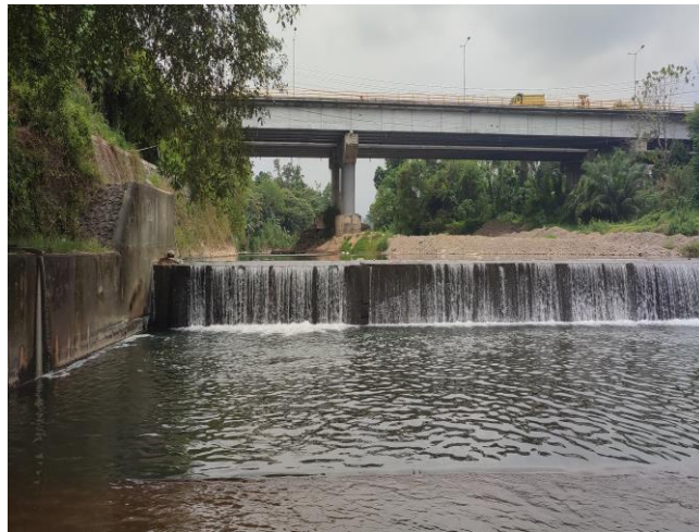
Gambar 1. 2 Kondisi Groundsill di Lapangan (Sumber: Dokumen Pribadi)
