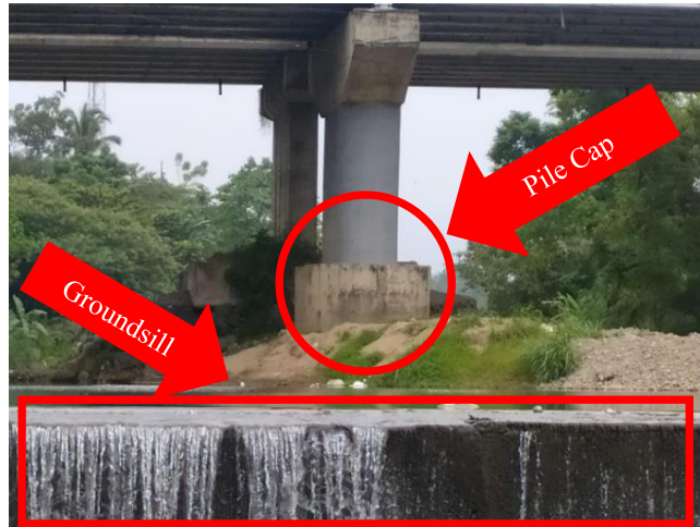
Gambar 1. 1 Kondisi Tiang Jembatan Kuranji (Sumber: Dokumen Pribadi)
