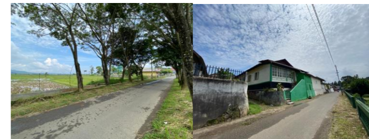
Gambar 1. 13 Kondisi Jalan Y.Dt.Kayo dan Jl. Mr.Moh.Nazif Sumber : Penulis, 2023
