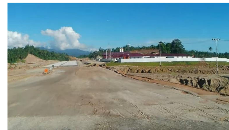
Gambar 1. 4 Kondisi pada titik rest area km 23 Sumber : Dokumen pribadi, 2023
