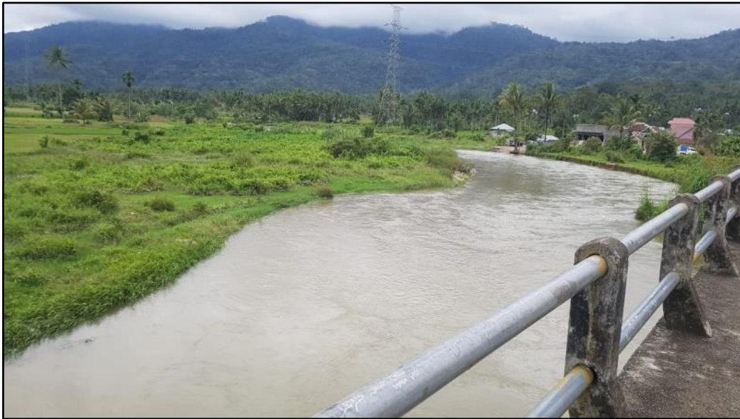
Gambar 1.1 Survey Kondisi Sungai Sumber : Dokumentasi Lapangan, 2019
