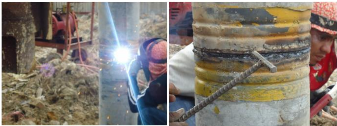
Gambar 2. 6 Pengelasan Sambungan dan Hasil Pengelasan Sambungan Tiang Pancang
