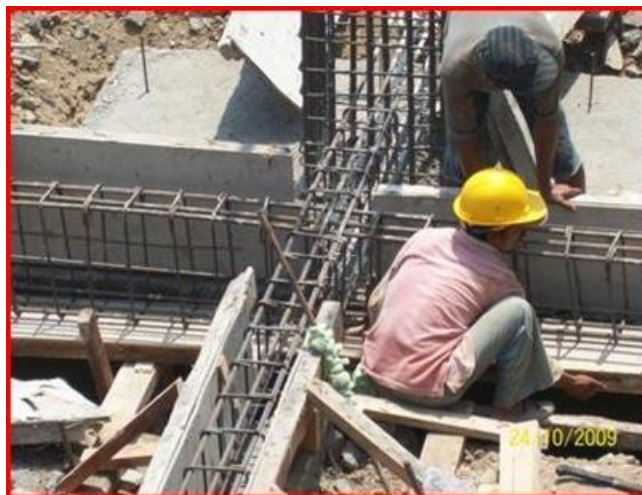
Gambar 2. 13 Pekerjaan Penulangan Tie Beam
