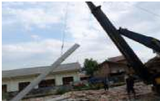
Gambar 2. 4 Handling Spun Pile Menggunakan Crane
