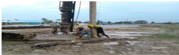
Gambar 2. 5 Proses Penyambungan Tiang Pancang
