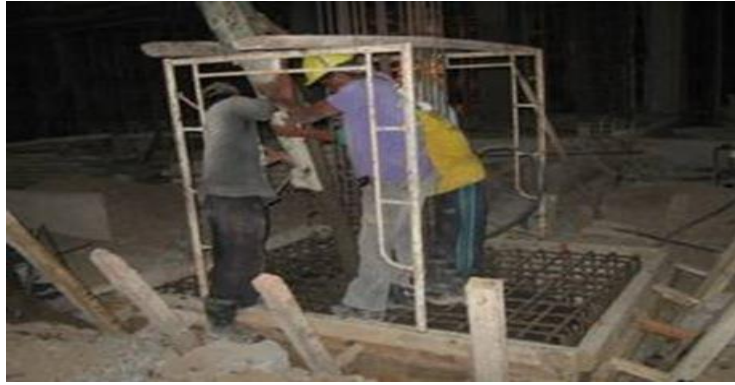
Gambar 2. 17 Pengecoran Lewat Talang Untuk Menjangkau Tie Beam yang Jauh
