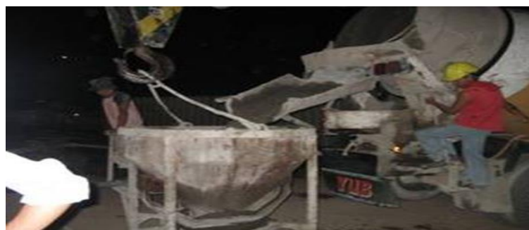
Gambar 2. 16 Pengecoran Tie Beam dengan Beton Readymix
