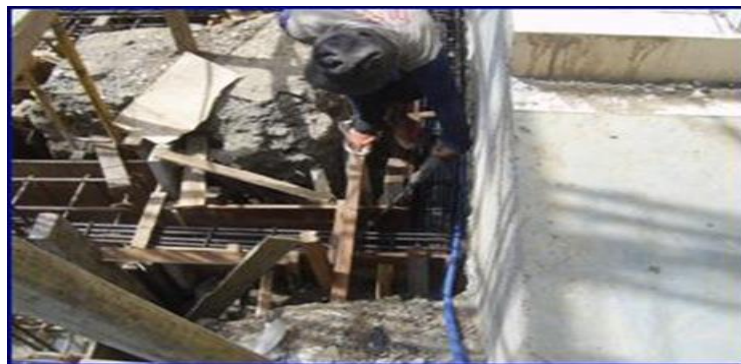
Gambar 2. 15 Membersihkan Tulangan dan Bekisting
