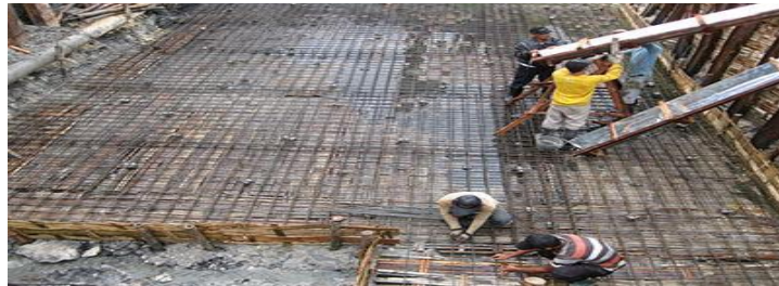
Gambar 2. 25 Pekerjaan Plat Lantai
