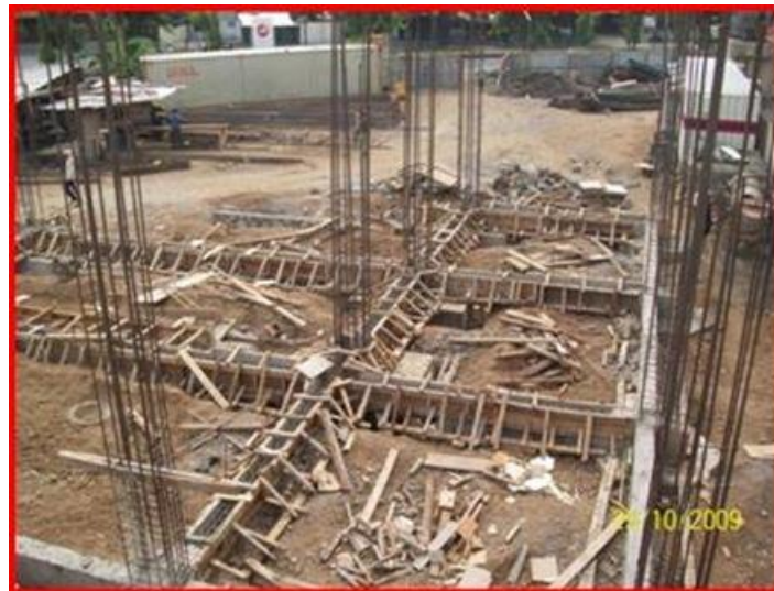
Gambar 2. 14 Pengerjaan Bekisting Tie Beam
