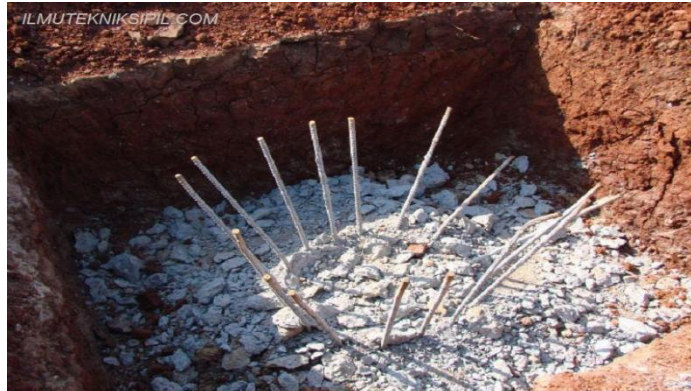
Gambar 2. 9 Pembobokan Tiang Pancang
