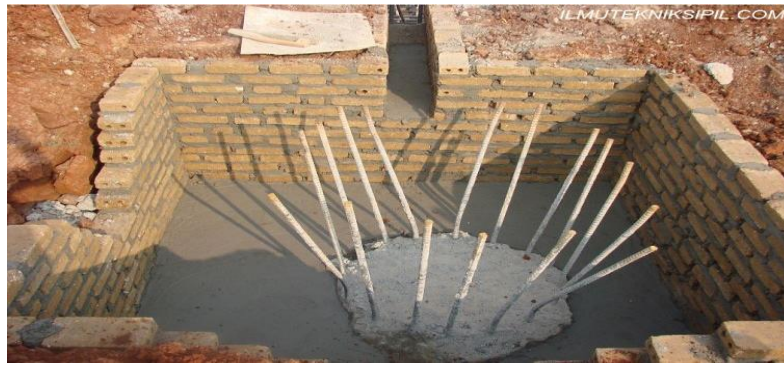
Gambar 2. 10 Pekerjaan Urugan Pasir, Lantai Kerja, Bekisting
