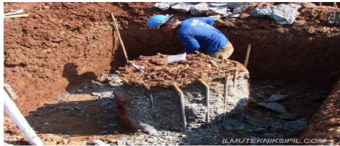
Gambar 2. 8 Pekerjaan Galian Pile Cap
