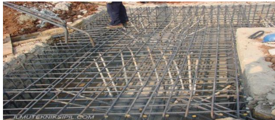
Gambar 2. 11 Pengerjaan Penulangan Pile Cap
