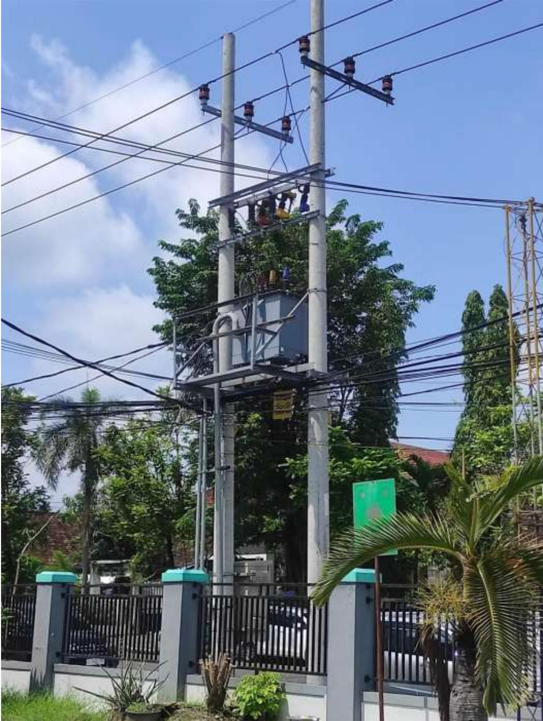
**Gambar Trafo pada SUTM 20 KV**
