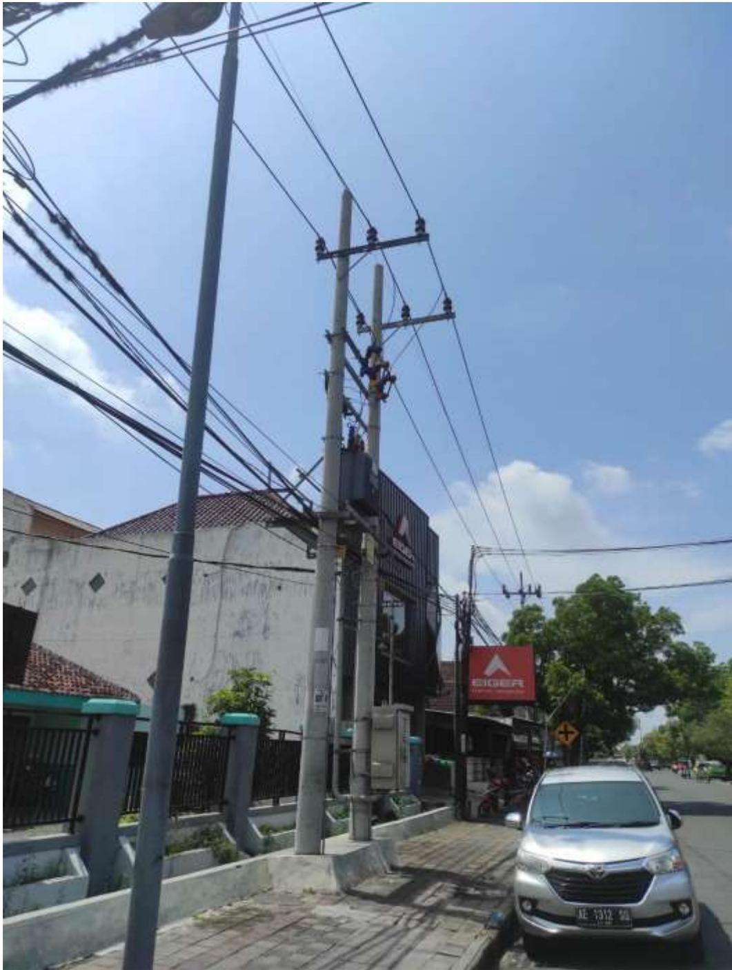
**Gambar Trafo pada SUTM 20 KV**
