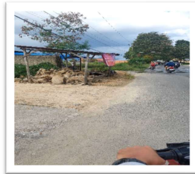
Tidak ada trotoar
