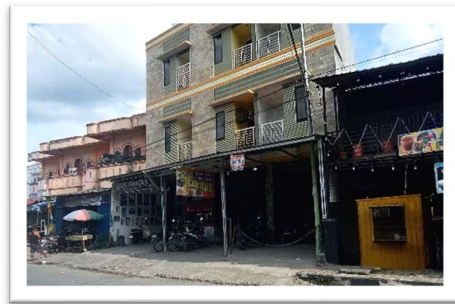
Bangunan yang menutupi trotoar
