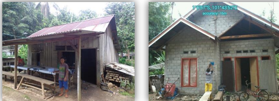
Gambar 1.1. Photo kondisi rumah yang sebelum diperbaiki dan kondisi rumah yang sudah dibangun kembali (Dinas Perkimtan Dharmasraya, 2019)
