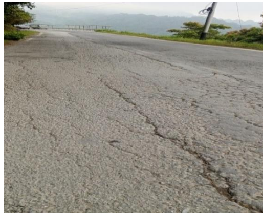
Gambar 1.2 Retak Memanjang
