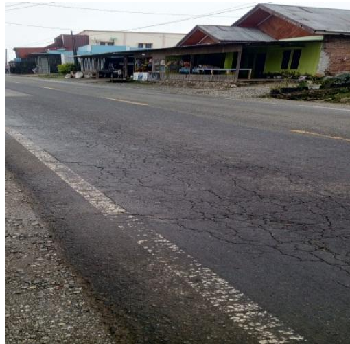
Gambar 1.6 Retak Memanjang
