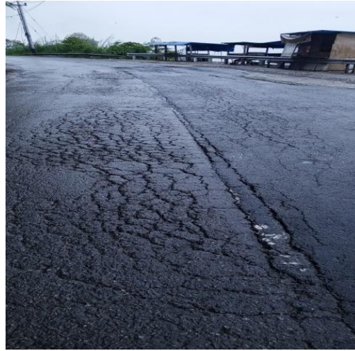
Gambar 1. 8 Retak Kulit Buaya
