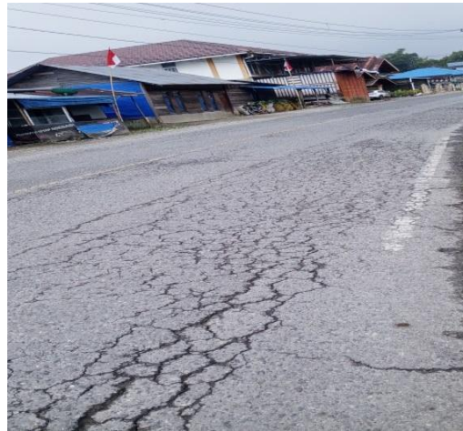
Gambar 1.4 Retak Kulit Buaya
