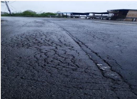
Gambar 1. 9 Retak Kulit Buaya
