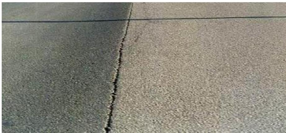
Gambar 2. 12 Kerusakan reflektif sambungan (*joint reflective cracks*)
