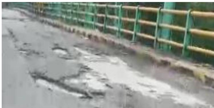
Gambar 1. 4 Kerusakan lubang (*pothole*)
