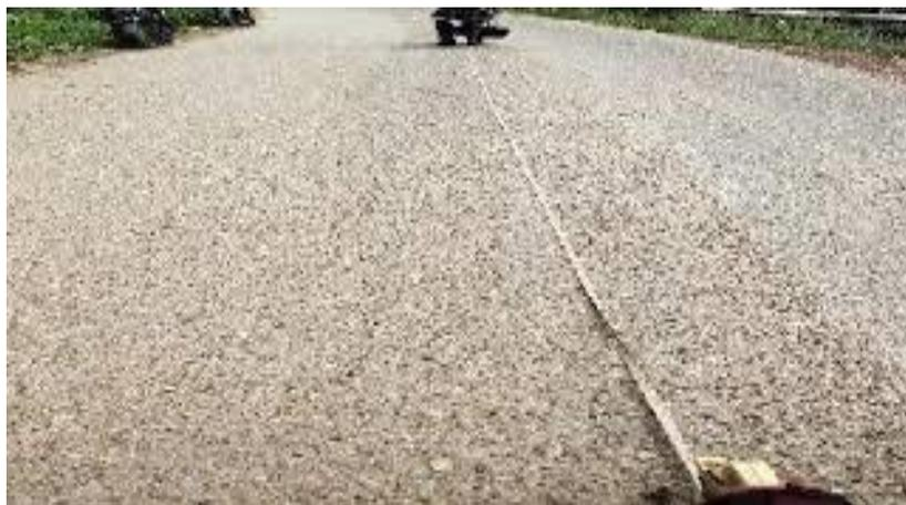
Gambar 2. 20 Kerusakan pengausan atau (*polished aggregate*)
