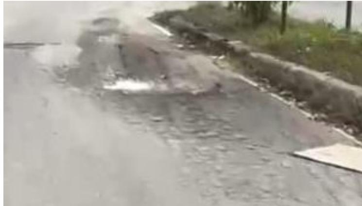
Gambar 1. 3 Kerusakan slip (*slippage cracks*)
