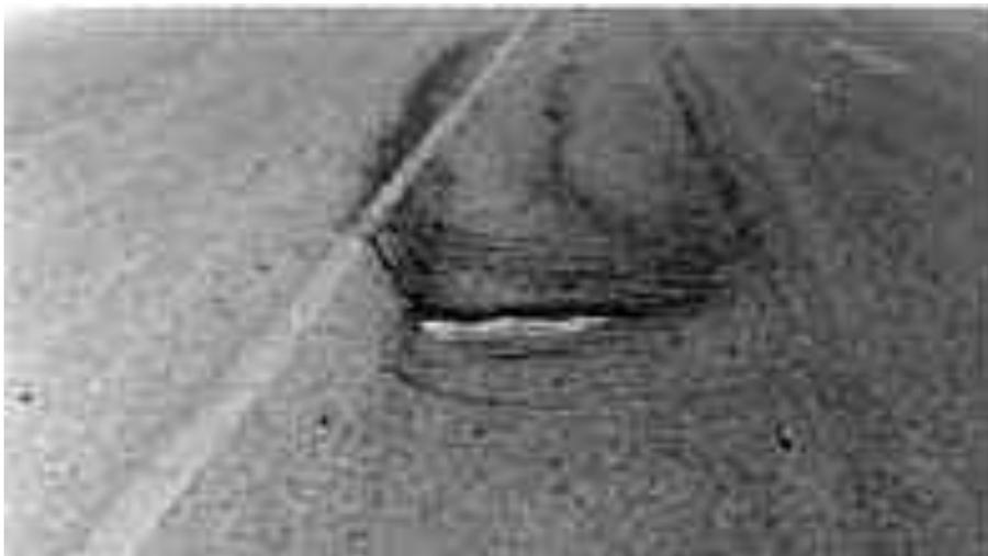
Gambar 2. 15 Kerusakan slip (*slippage cracks*)
