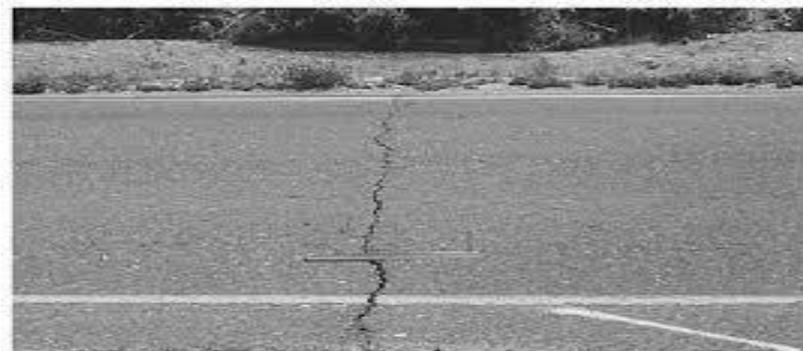
Gambar 2. 11 Kerusakan retak melintang (*transverse cracks*)
