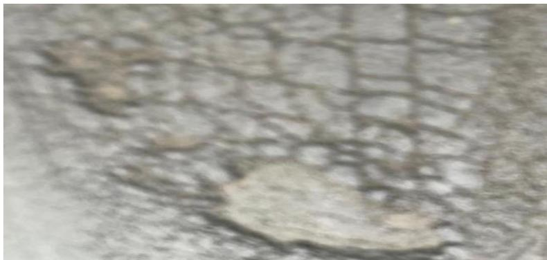
Gambar 1. 1 Kerusakan retak kulit buaya (*alligator cracks*)
