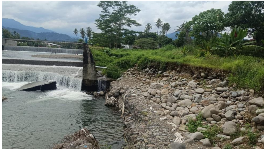
Gambar 1. 2 Kondisi sisi Groundsill di Lapangan (Sumber : Dokumentasi Penulis 2024)
