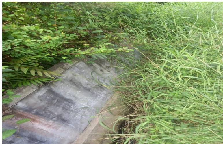
Gambar 1. 1 Adanya penumpukan sedimentasi dan tumbuh – tumbuhan pada drainase
