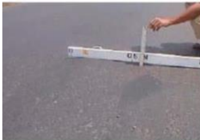
gambar 2. 17 Contoh Kerusakan Alur ( Rutting )
