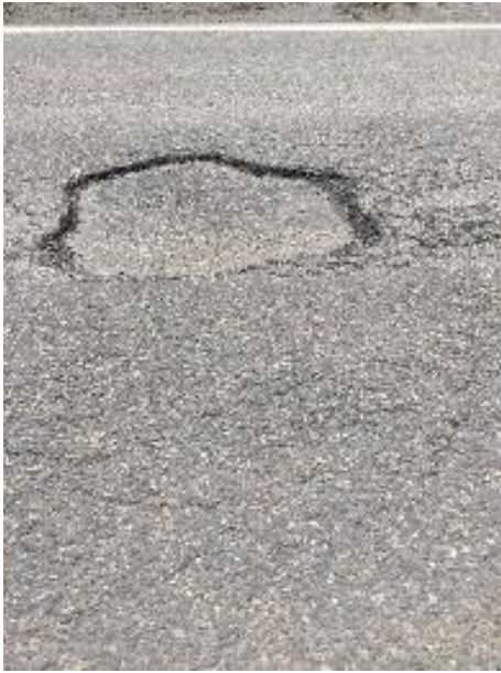
Gambar 4. 2 Kerusakan Lubang
