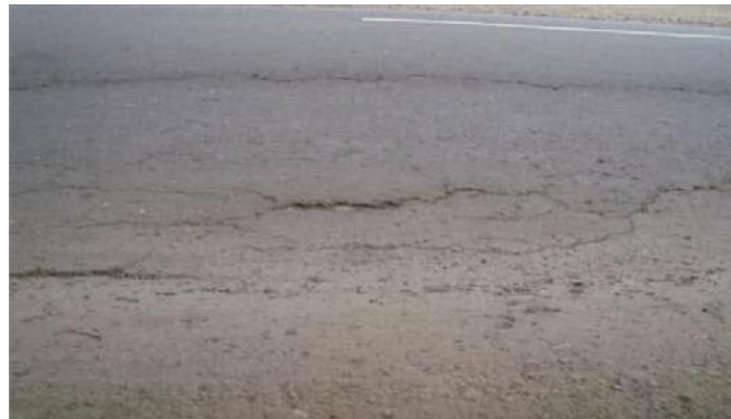
gambar 2. 6 Contoh Kerusakan Cekungan ( Bumb and Sags )
