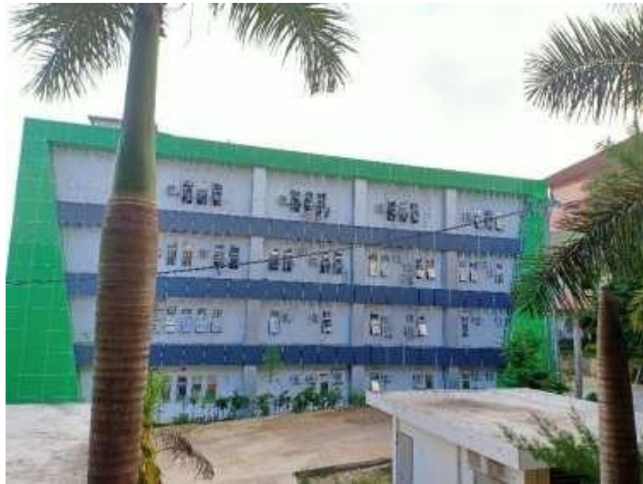
Gambar 1.2 Proyek Gedung Rawat Inap RSUD H. Abdul manap (Sumber : Dokumentasi Lapangan, 16 Juni 2020)
