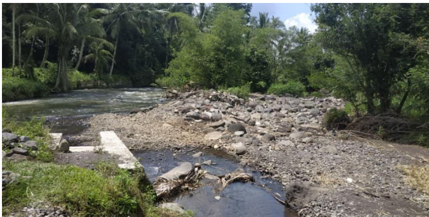
Gambar 1.1 Kondisi Terkini Bendung (Sumber : Dokumentasi Lapangan)
