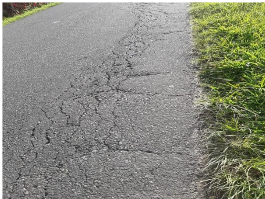
a. Retak memanjang Sta 156+655
