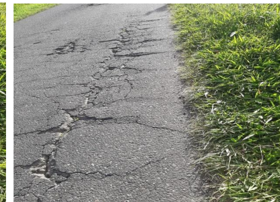
b. Retak memanjang Sta 159+705
