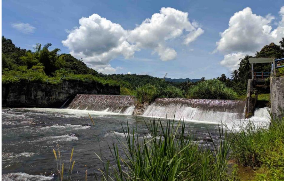
Gambar 1. 1 Kondisi Bendung Bandar Baru Batang Tampunik (Sumber : Dokumentasi survei lapangan)
